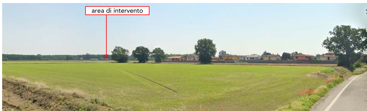
Figura 3.62 – Viste a distanze progressive v7, v8 e v9 rivolte all'area di intervento dalla Sp29 procedendo da Alagna in direzione Scaldasole.
